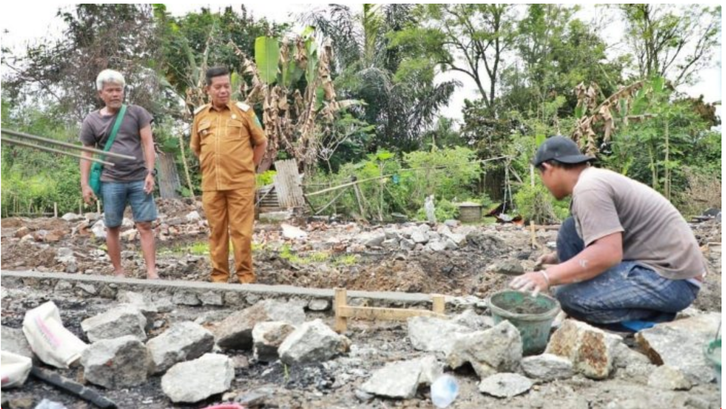
Bupati Simalungun Radiapoh Hasiholan Sinaga saat meninjau pelaksanaan pembangunan ke 7 rumah milik warga
